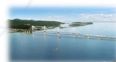
国内首座公铁同层跨海大桥，珠海市金海跨海大桥正式开工
