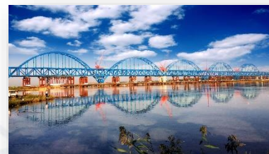
银川机场黄河特大桥
