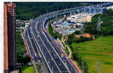
厦门市马青路新建高架桥
