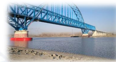
浮动式阻尼消能桥梁防撞设施成功应用
